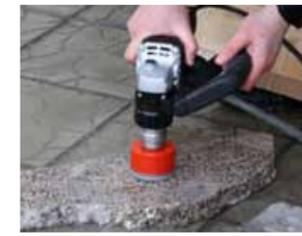
Это требуется в случае вывода инженерных коммуникаций внутри помещений, установки крепежных элементов на фасадах, отделанных керамогранитом или натуральным камнем. Применение невоспещенных технологий (традиционная резка) ведет к разрушению целостности плиток и в целом резко снижает эстетические свойства такой отделки.
