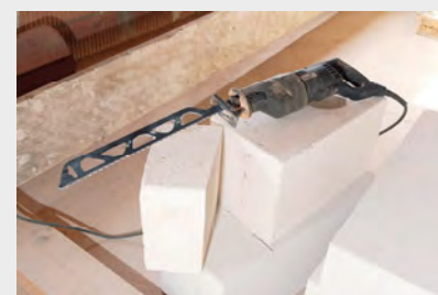
Резка в аэрированном бетоне
